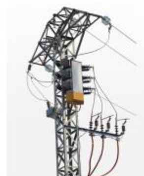
Interruptores con SF6
